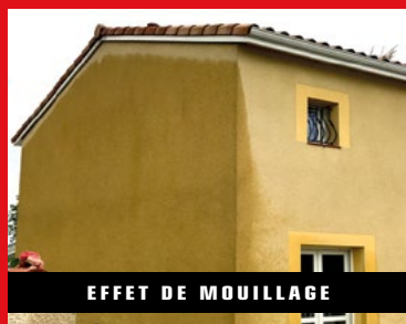
REMONTÉES D'HUMIDITÉ
