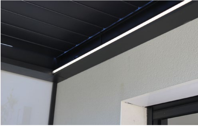
Focus sur un des deux bandeaux leds. Un variateur d'intensité contrôlable via une télécommande permet de régler la luminosité de l'éclairage.
