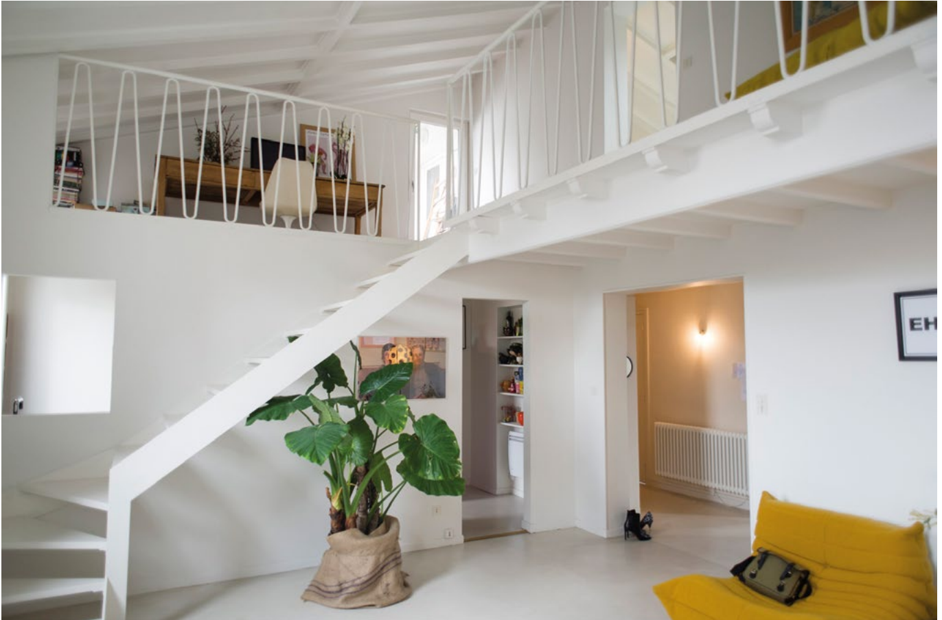
Le nouvel escalier et le garde-corps style années 1960 ont été conçus sur mesure par la décoratrice. L'ouverture sous escalier a été créée pour faciliter le passage entre le séjour et la cuisine. L'ancien couloir sombre revêt dorénavant une teinte beige lumineuse.
