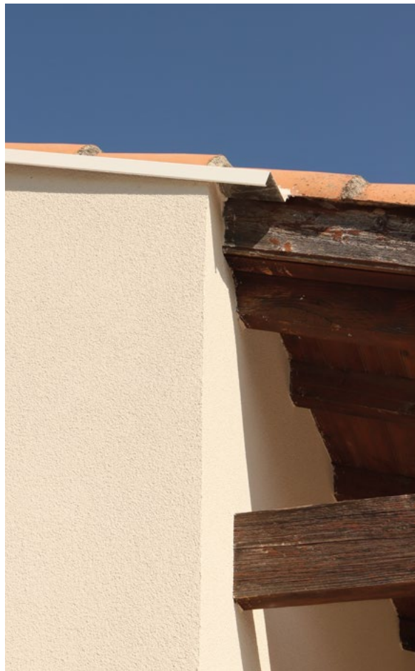
Mur pignon. L'isolation par l'extérieur en fibre de bois a induit une surépaisseur du mur pignon. En partie haute, elle a été recouverte d'une couvertine.
