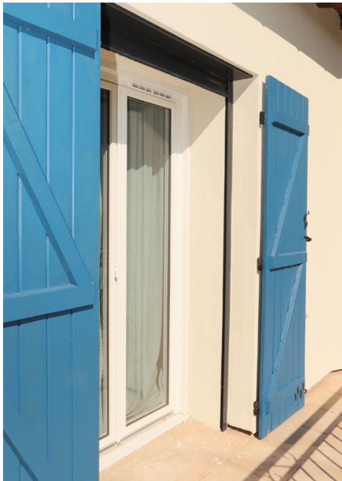
Un isolant qui respire. Sur cette photo, on distingue parfaitement l'épaisseur de l'isolant extérieur, entre la descente du volet roulant et le volet bleu. Les volets en bois bleus, déposés le temps de la pose de l'isolant, ont été réinstallés en fin de chantier. La partie basse de l'isolant ne touche pas le sol pour laisser une lame d'air le prémunir de toute remontée d'humidité.
