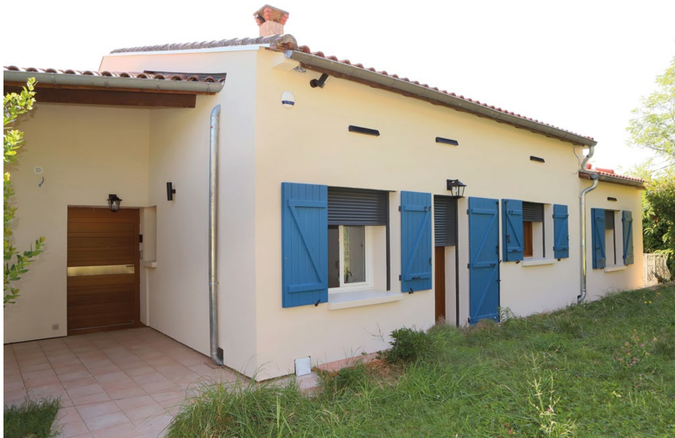
Façade nord. Les propriétaires ont souhaité l'installation de volets roulants intégrés dans l'isolation par l'extérieur. Par souci esthétique entre autres, ils ont également souhaité que les volets en bois bleus soient conservés.
