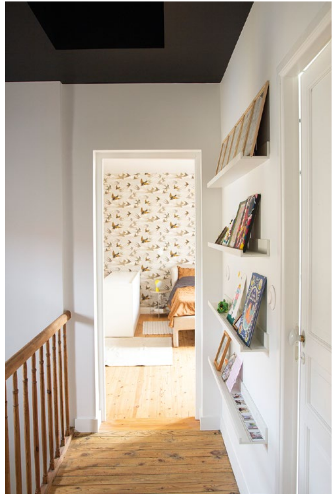
Couloir. À l'étage, le parquet d'origine a été poncé et huilé. Le plafond a été peint en noir pour casser la hauteur dans l'escalier. Portes neuves avec poignées effet porcelaine Leroy Merlin, dans l'esprit de l'existant.
